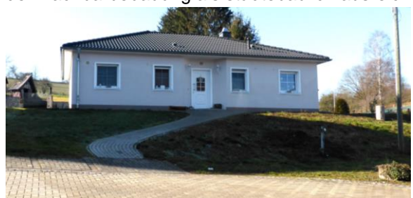
Bestand in südlicher Richtung mit anderen Baustil
